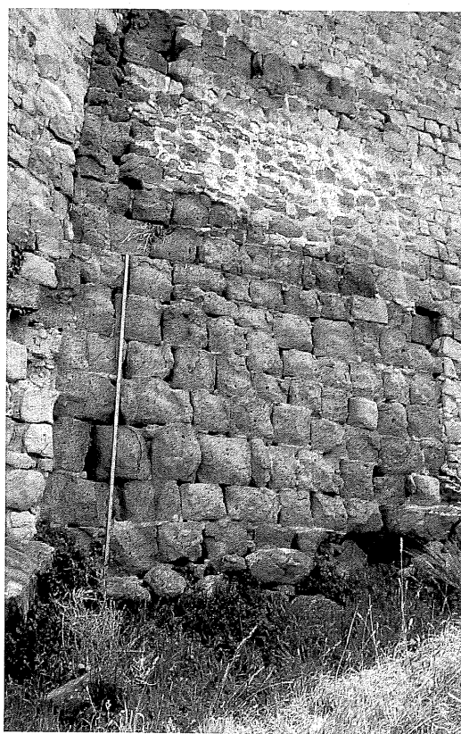
20/ Segmento Torre 3: Esterno - Il reimpiego dei blocchi in tufo pre-romani nella fase di fondazione medievale.
