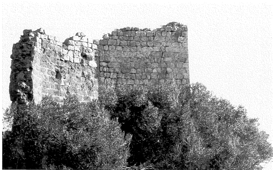
15/ Porta 2: Esterno – Sono evidenti le merlature della III fase in tufo inglobate nel rialzamento della V fase costruttiva.
