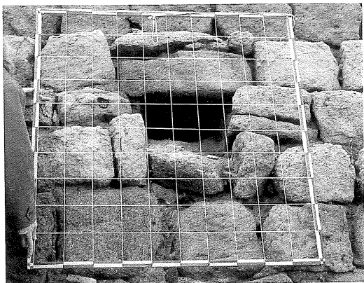
21/ Torre 3: Esterno – La bocca di uscita di caditoia.
