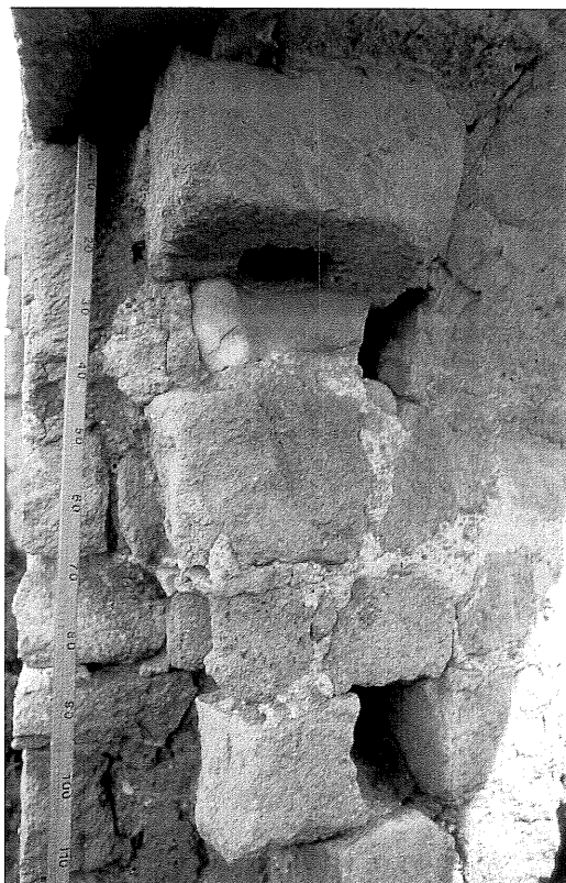
15/ Porta 2: Esterno – Sono evidenti le merlature della III fase in tufo inglobate nel rialzamento della V fase costruttiva.
