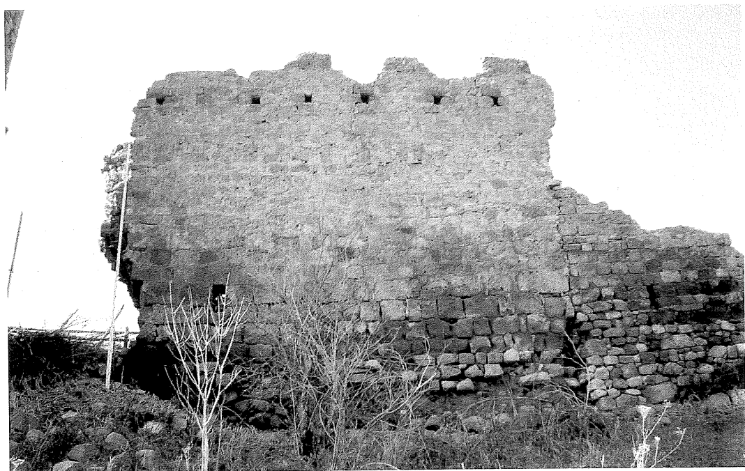
22/ Cortina 5: Esterno – Sono evidenti la foderatura al piede del muro, la II fase in tufo al centro della parete e il rialzamento con i fori di alloggiamento delle caditoie lignee a sbalzo e le merlature delle VII fase.
