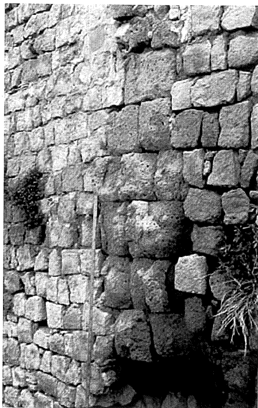
19/ Segmento Torre 3: Esterno - Il lacerto delle mura pre-romane.
